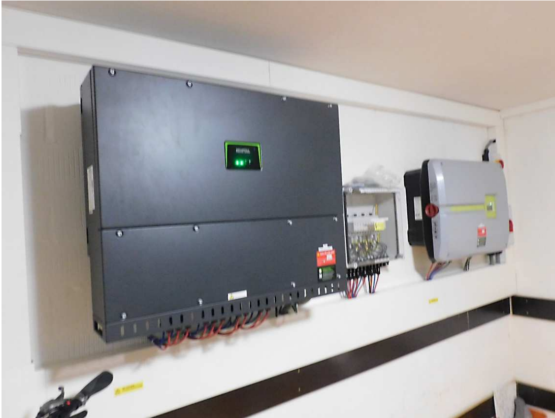
Wechselrichter Kostal PIKO CI 50 (links) - Kostal PIKO CI 30 (rechts)
