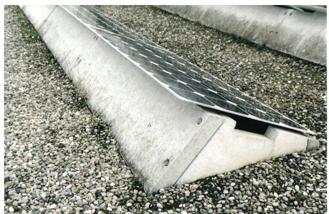
Aufständerung SOFREL – Module verleimt
