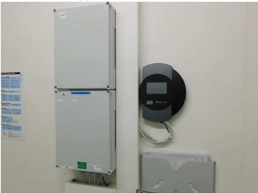
**„Solalog“ - Solardatenübertragungsgerät**
