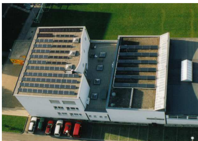
Trakt 4: links unsere 5. Bauetappe rechts solare Warmwasseranlage
