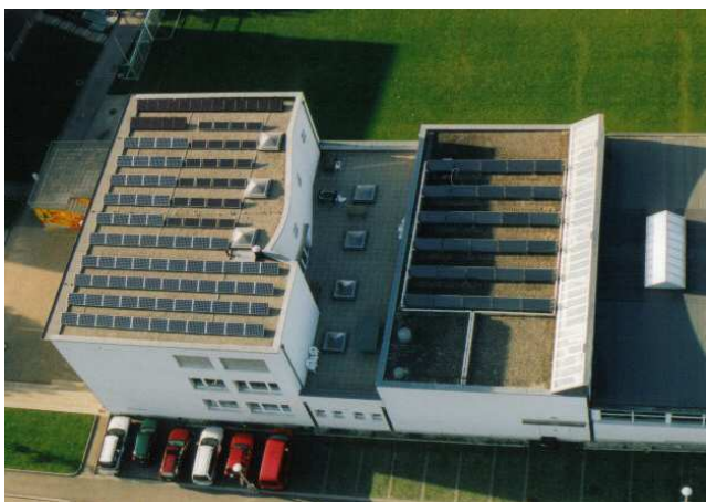
Trakt 4: links unsere 5. Bauetappe rechts solare Warmwasseranlage
