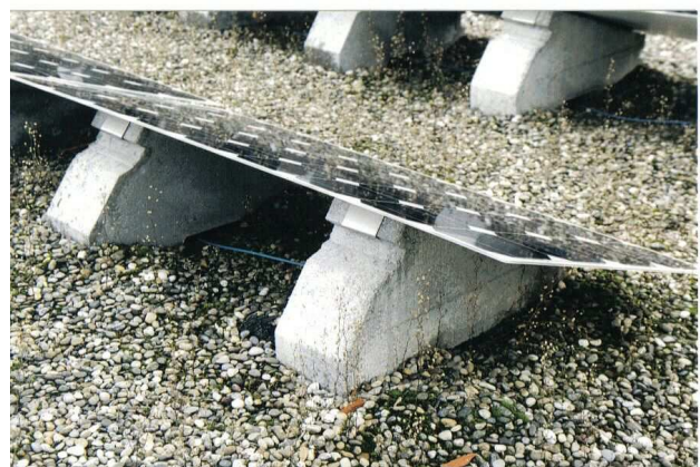
Aufständigung SOFREL N95 mit Schnell-Montage-Vorrichtung
