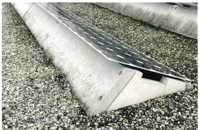
Aufständerung SOFREL – Module verleimt
