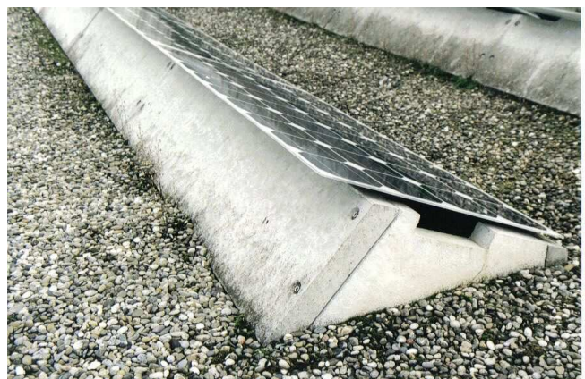
Aufständerung SOFREL – Module verleimt
