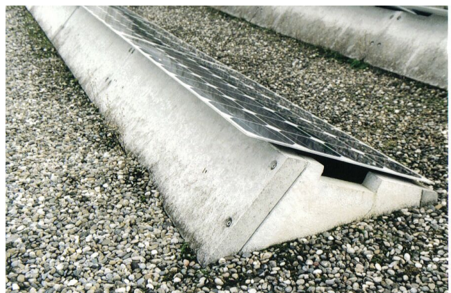
Aufständerung SOFREL – Module verleimt
