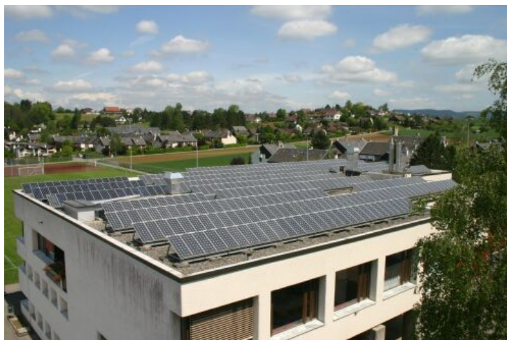
Mehrzweckhalle – Trakt 2 – 2. Bauetappe linke, obere Ecke
