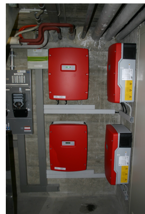
SMA Sunny Mini Central 6000A (seit 2006)
