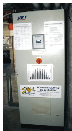
Wechselrichter 25 kW SMA WR-T (1992-2006)
