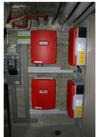
SMA Sunny Mini Central 6000A (seit 2006)
