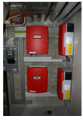
SMA Sunny Mini Central 6000A (seit 2006)
