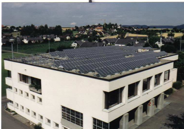
Beton-/Metall-Aufständerung
