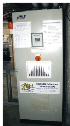
Wechselrichter 25 kW SMA WR-T (1992-2006)
